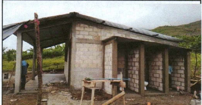
Foto 2: Mejoramiento de servicios sanitarios y sus accesorios
