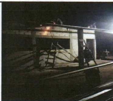
Foto 5: Estructura de techo y cubierta de lámina
