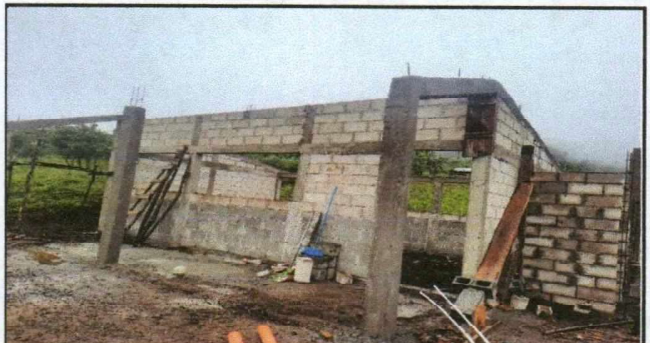
Foto 4: Mejoramiento de puertas, pisos y ventanas de aula de tercero primaria
